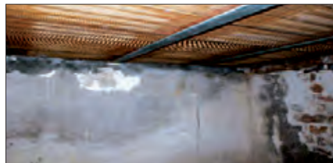
Solaio in putrelle e tavelloni
